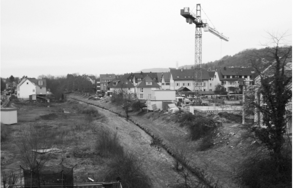
Das Steinhilber-Grundstück 2011 zu Beginn der Bebauung
